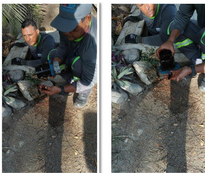
Ilustración 33 Mantenimiento Equipo De Medición Hotel Irotama Rodadero. 25 De diciembre De 2024
