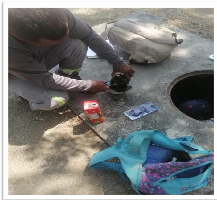
Póliza 58271 Cancha de Softbol Villa Olímpica
