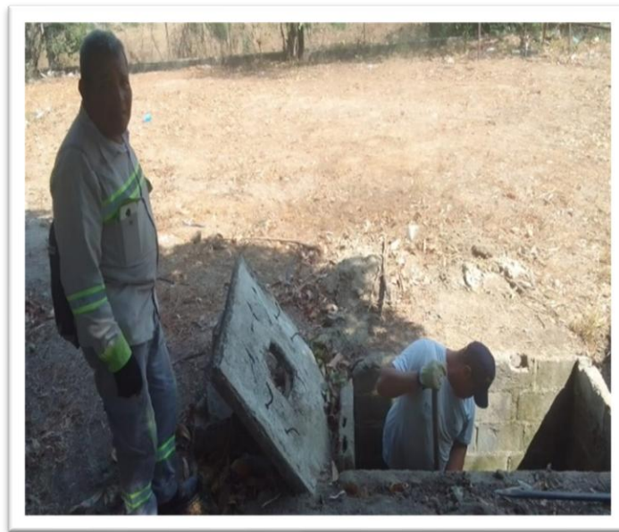
Trabajos de reposición de medidor del medidor de 4 pulgada Póliza 18735 ZONA FRANCA INDUSTRIAL
