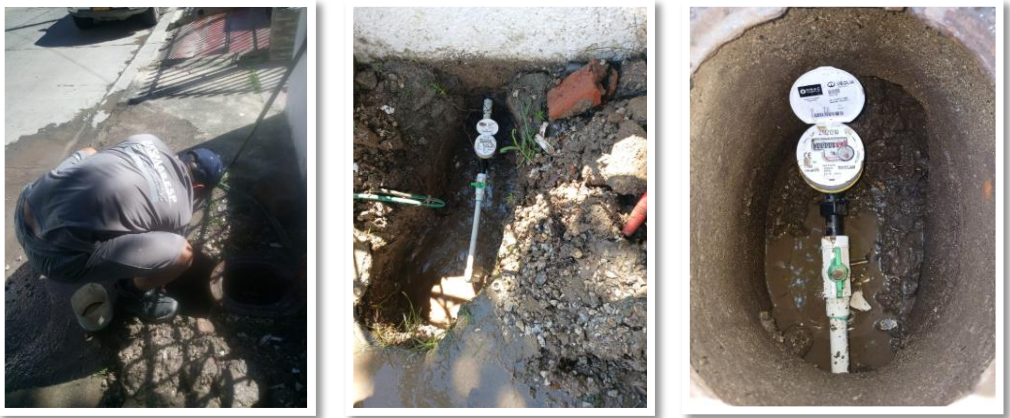
Ilustración 37 Normalización con instalación de medidores por revisiones y/o negociación de irregularidades
