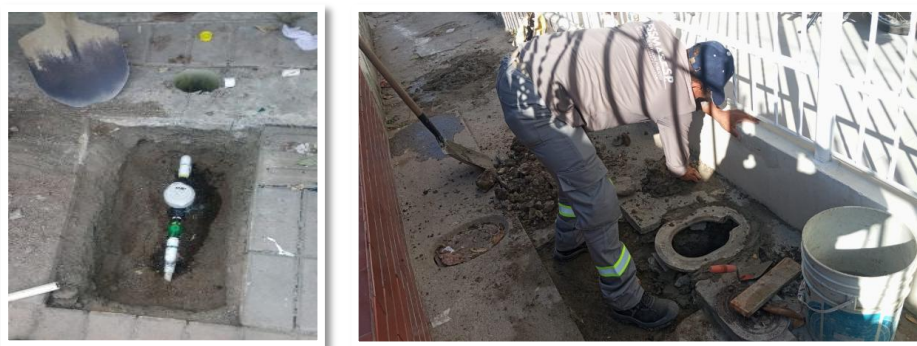
Ilustración 36 Normalización con instalación de medidor proyecto calle 30
