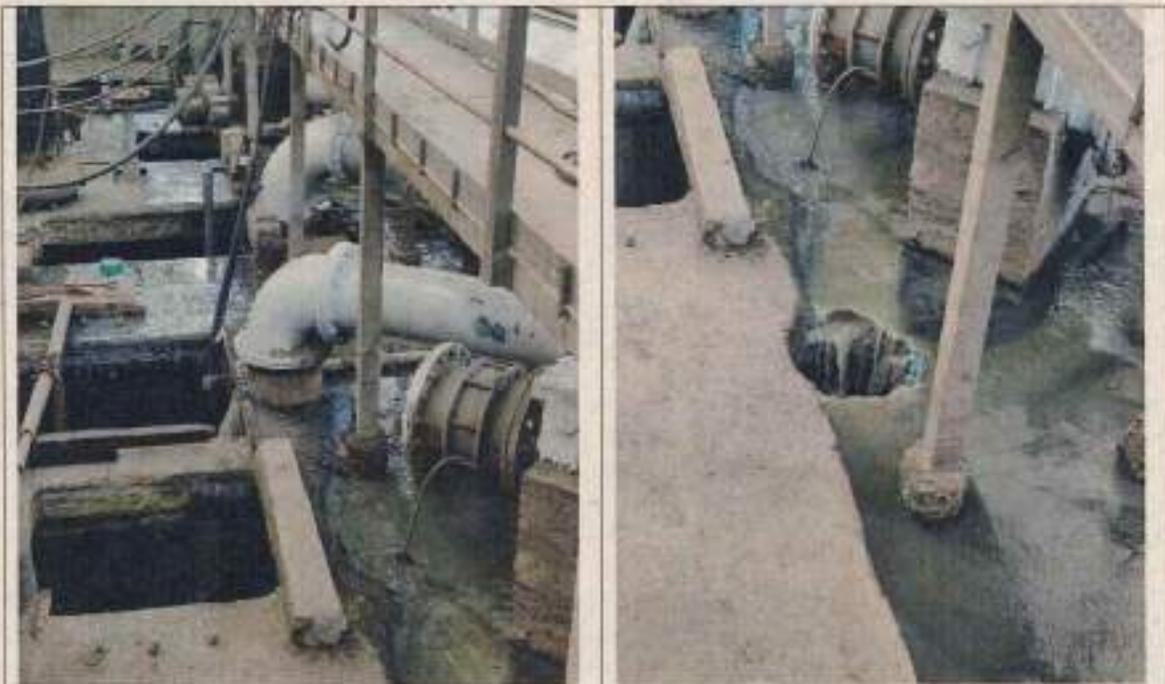
**Fotografía 10.** Losas de cubierta en contacto directo con agua residual – Zonas parcialmente demolidas –
