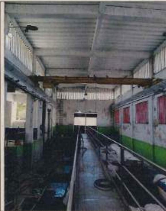
**Fotografía 3.** Vista general edificación de un nivel - pódicos resistentes a momento de concreto reforzado
