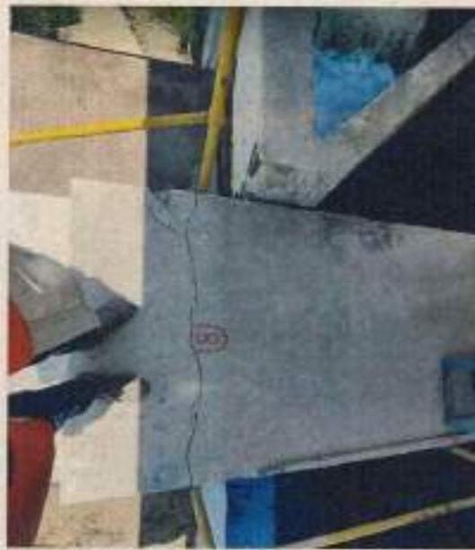
Fotografía 11. Agrietamiento por desplazamiento en los apoyos de la escalera
