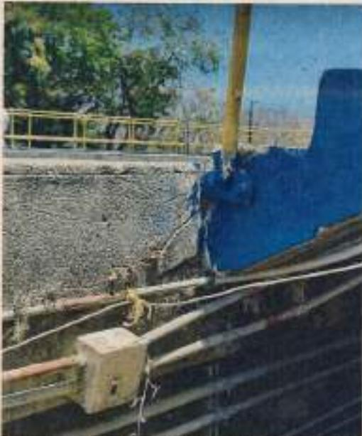
Fotografía 10. Agrietamiento en el apoyo de las escaleras
