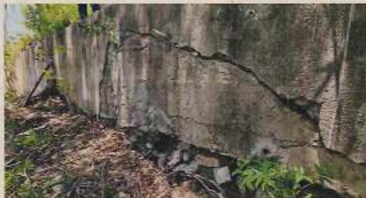
*Fotografía 9. Desprendimiento de la capa de acabado - Agrietamiento de la obra de contención*
