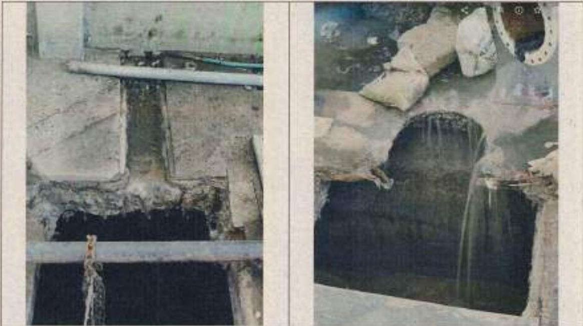
**Fotografía 9.** Demoliciones y afectaciones puntuales en losas de cubierta – Interrupción y exposición de barras acero de refuerzo
