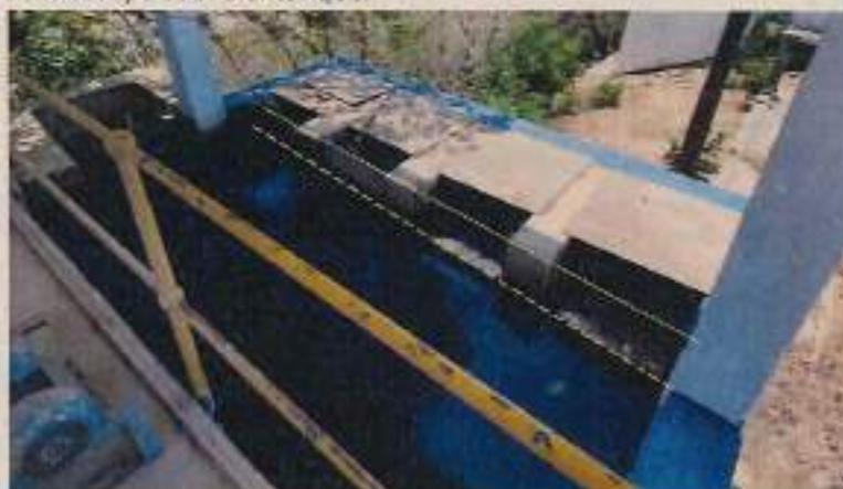
Fotografía 15. Agrietamiento en el apoyo de las escaleras
