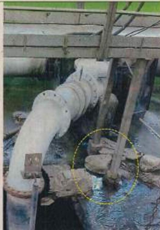
**Fotografía 8.** Condiciones insuficientes de anclaje para la plataforma de circulación sobre los tanques.
