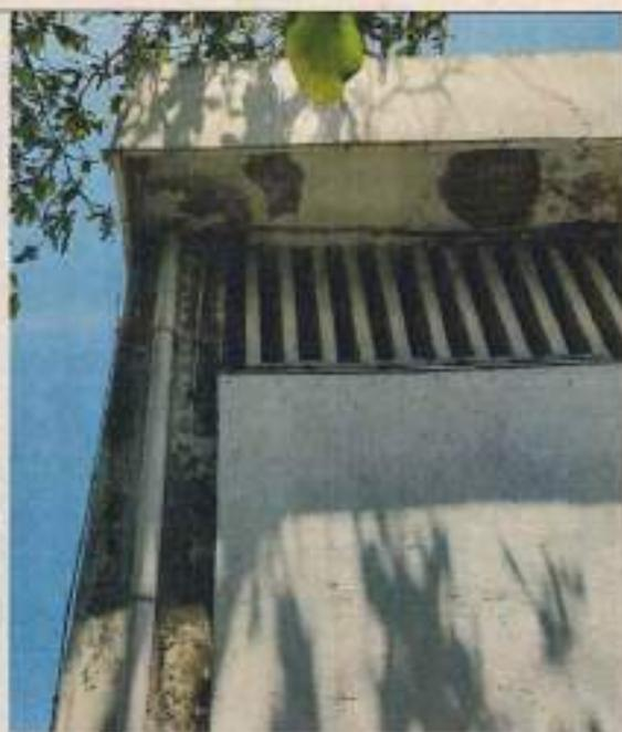
**Fotografía 6.** Elementos de concreto en fachada, desprendimiento de la capa de mortero y falta de la malla que evita el ingreso de aves.
