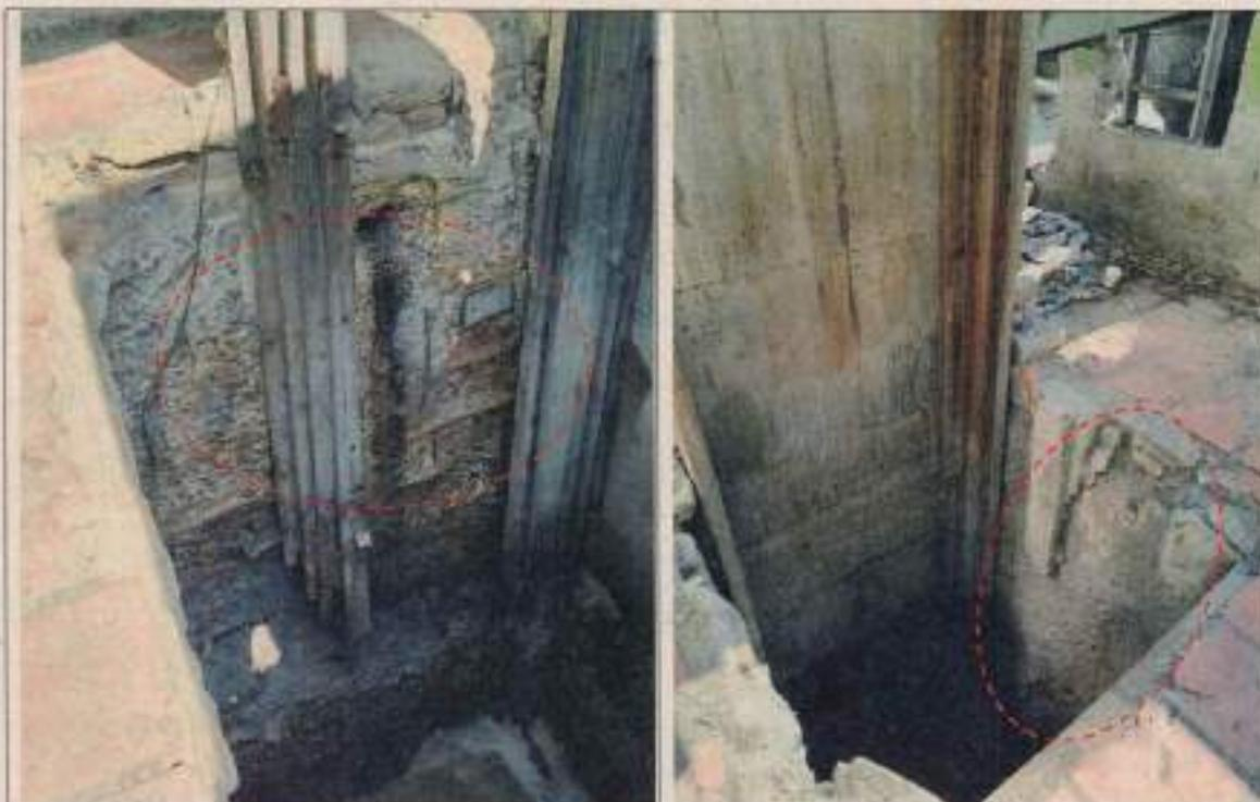
Fotografía 1. Deterioro en las paredes - Cajas de entrada para rejillas de cribado
