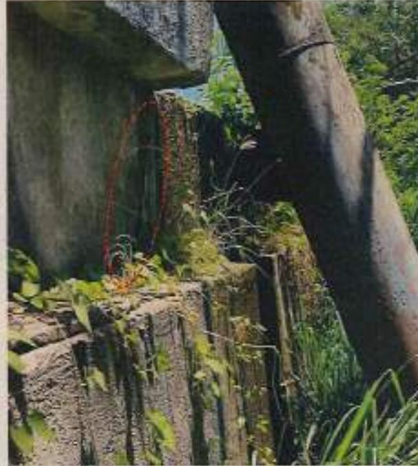
*Fotografía 8. Grieta bajo la cámara del costado derecho*
