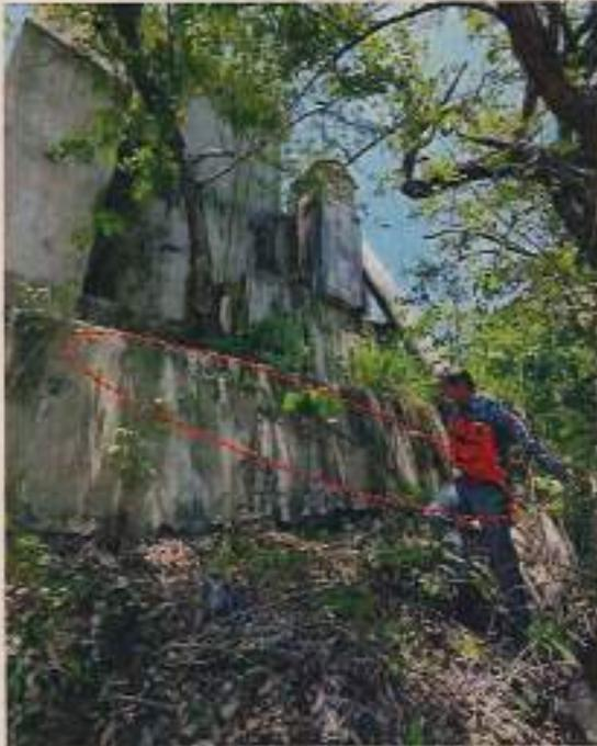
*Fotografía 7. Agrietamiento a lo largo de la obra de contención*
