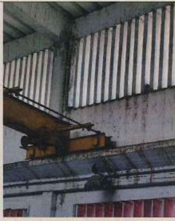
**Fotografía 4.** Degradación de las superficies de concreto por falta de mantenimiento
