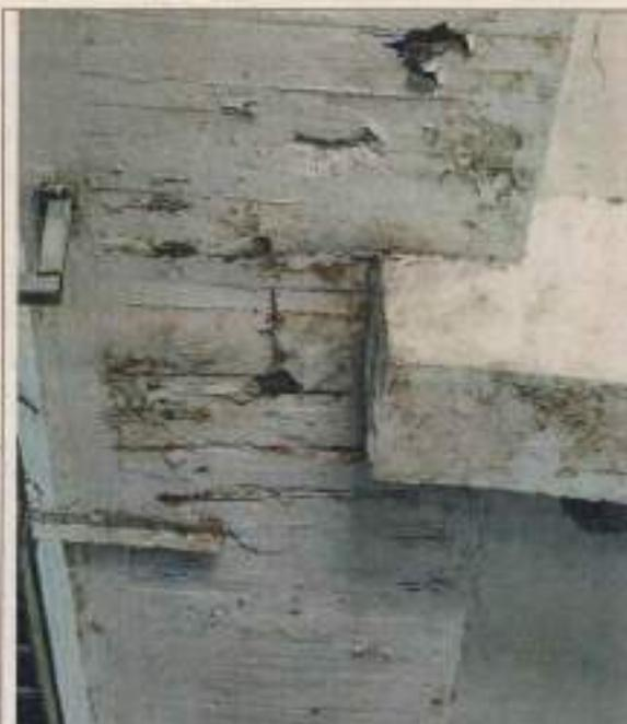
**Fotografía 5.** Elementos de concreto reforzado con muestras de corrosión – bajos recubrimientos.
